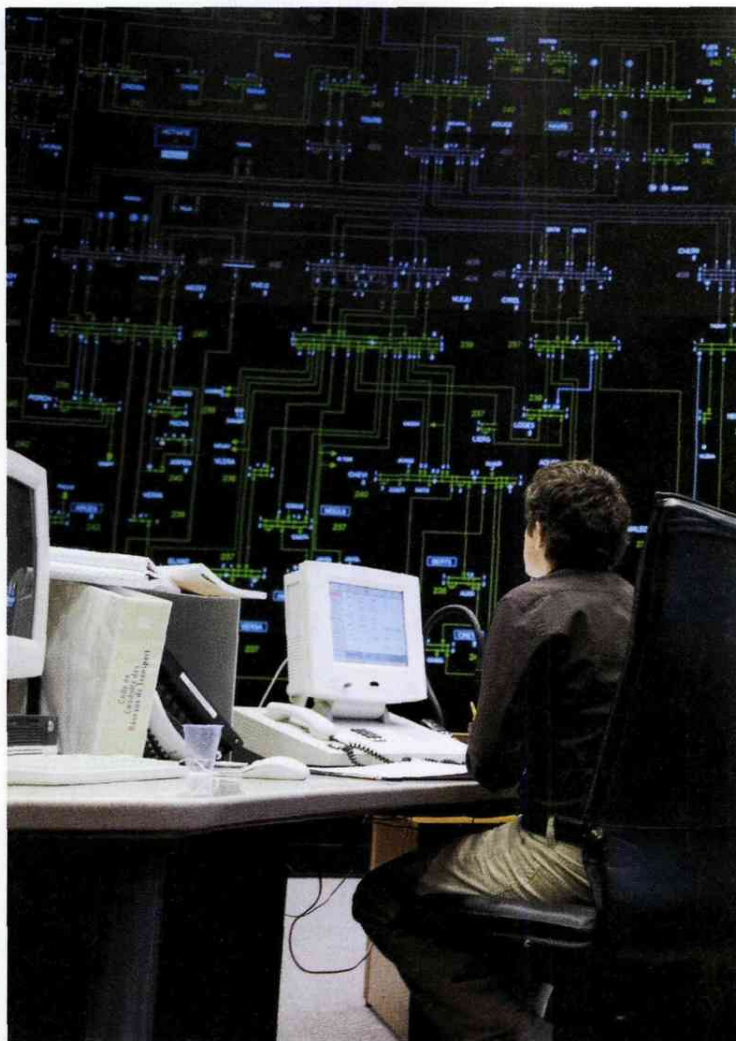
Le centre de conduite du réseau de RTE à Saint-Quentin-en-Yvelines supervise en temps réel l'équilibre entre la production et la consommation d'électricité.
